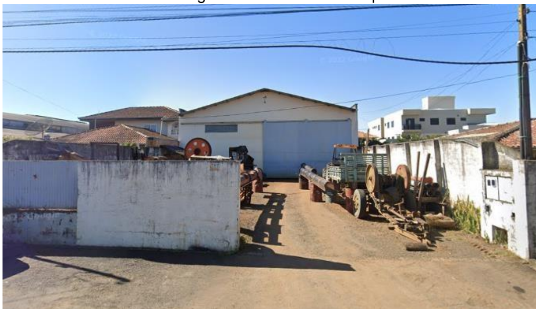
Imagem 3 – Fachada da empresa
