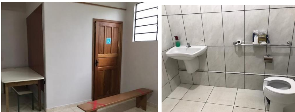
Figura 7 – Banheiro acessível: atualmente
