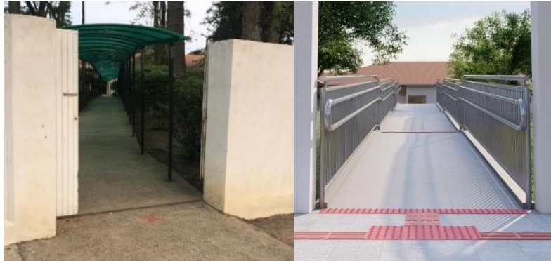
Figura 9 – Rampa 01: atualmente x proposta de adequação
