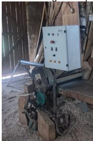
Figura 6- Montagem do painel
