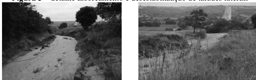
Figura 3 – detalhe assoreamento e desestabilização de taludes laterais
