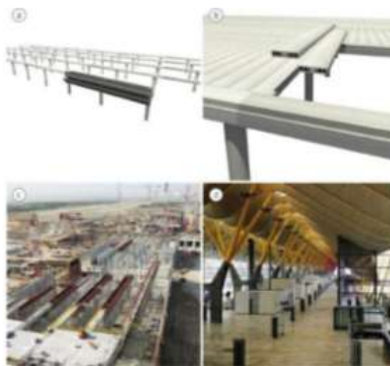
Figura 4: Ampliação do aeroporto de Madrid – Barajas, em Madrid (Espanha).
