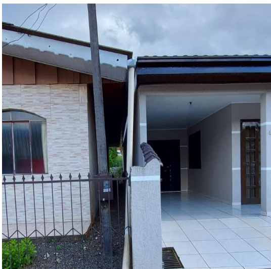
Figura 2- Parede de residência unifamiliar
