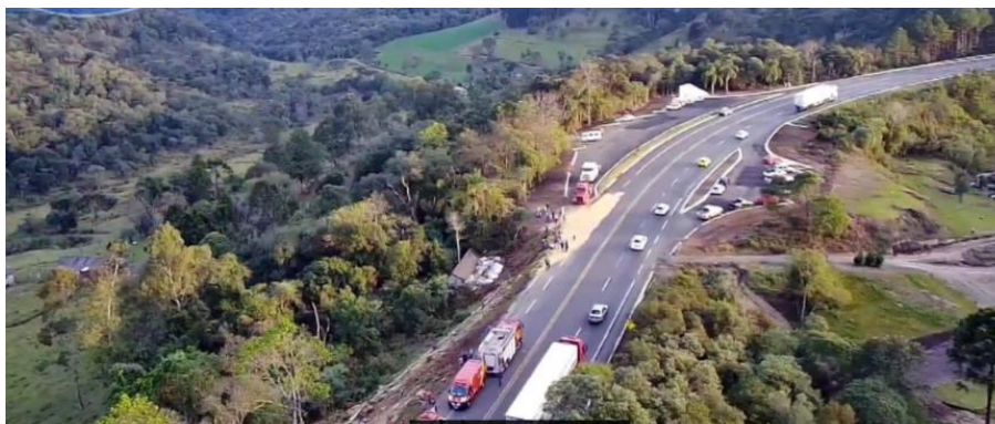
Figura 9 – Acidente na curva da Bica D'Água.
