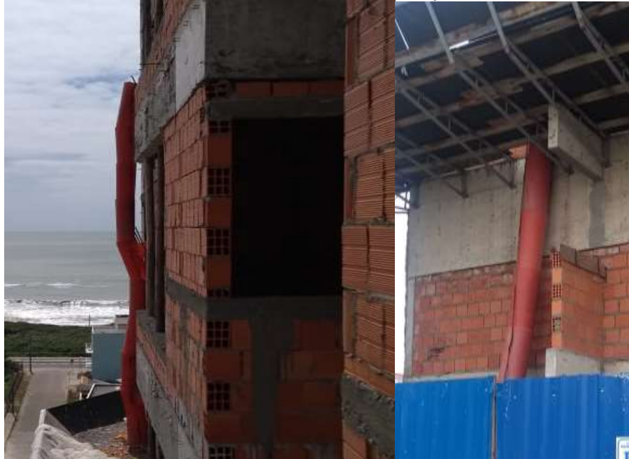
Foto 2 – Tubos de queda da edificação
