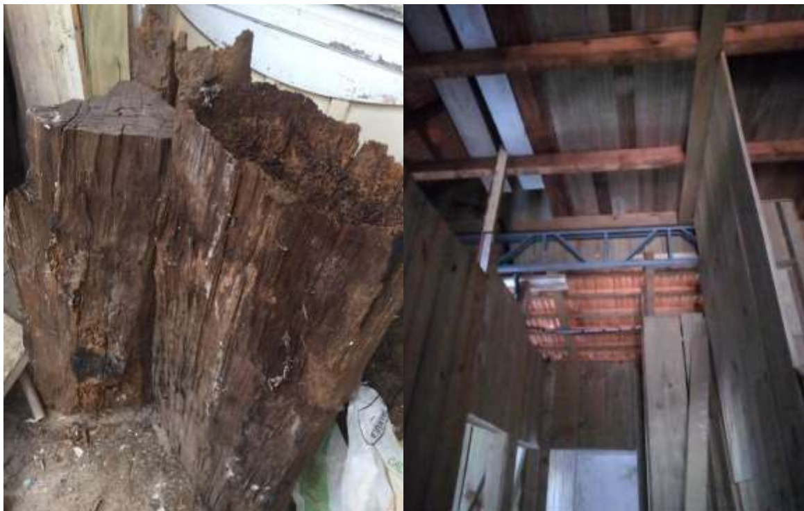
Imagem 6: Toras de Fundação Imagem 7: Treliça metálica
