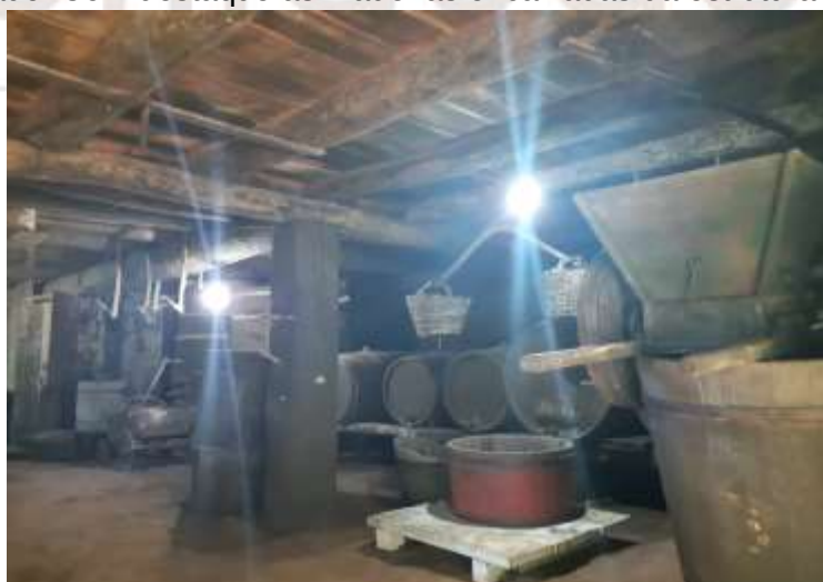
Figura 02: Porão da casa onde era feito o vinho, de chão de terra e semi-enterrado. Com destaque as madeiras encaixadas da estrutura da casa.
