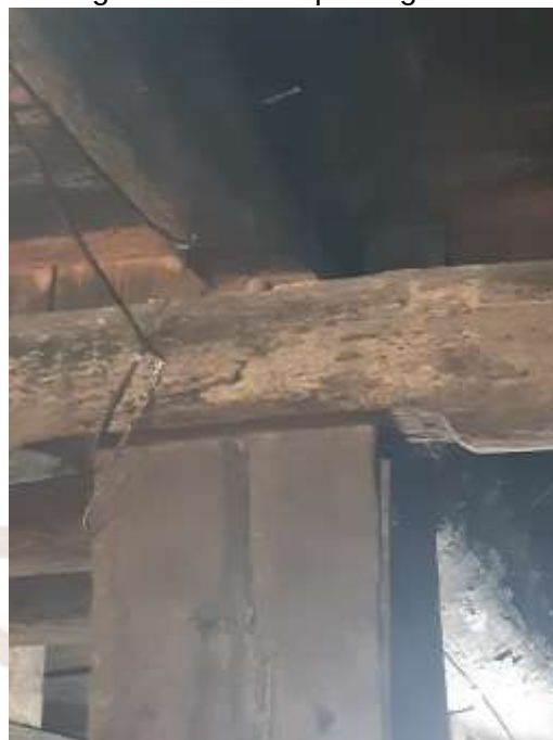
Figura 01: Detalhe do tarugo de madeira que segura a estrutura da Casa Sanber.
