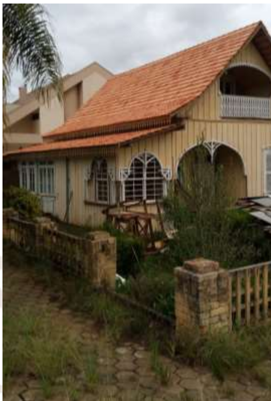
Imagem 5: Residência a ser analisada.
