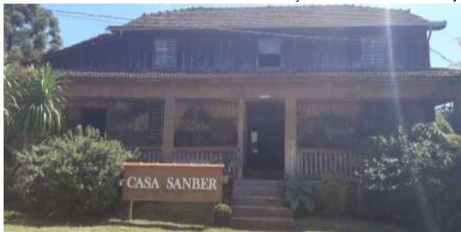
Figura 05: Entrada principal da Casa Sanber, com detalhe para a pintura externa e as aberturas. Também observamos a construção com tábuas e mata juntas.
