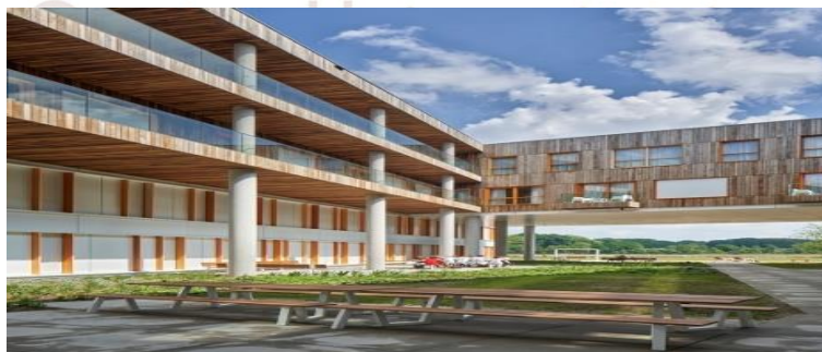
Figura 1: Terreno de Implantação do projeto e passarela de acesso.
