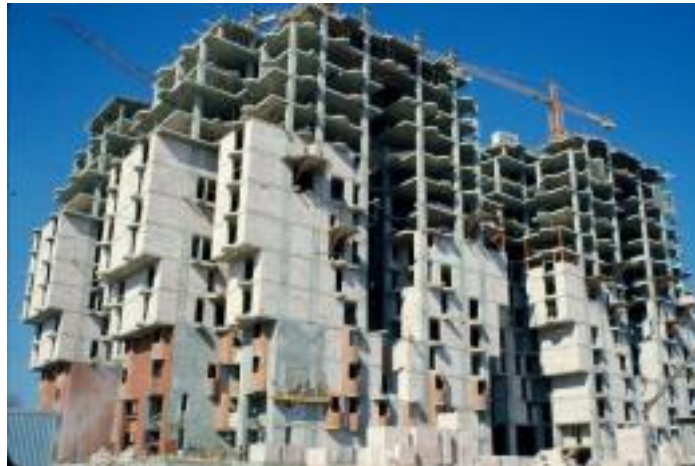
Figura 12 - Construção da estrutura
