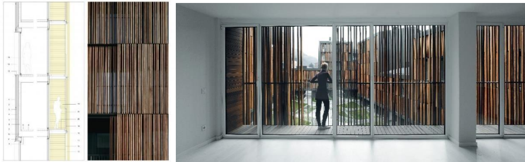
Figura 06 - Brises/Persianas fachada interna
