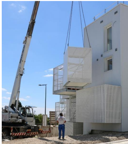
Figura 12: Instalação das varandas
