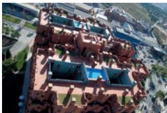
Figura 13 - Cobertura do edifício
