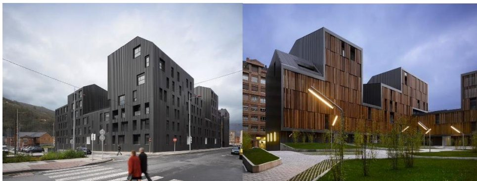
Figura 05 - Fachada externa e interna.
